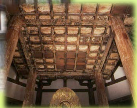
重要文化財 八角堂内陣装飾
